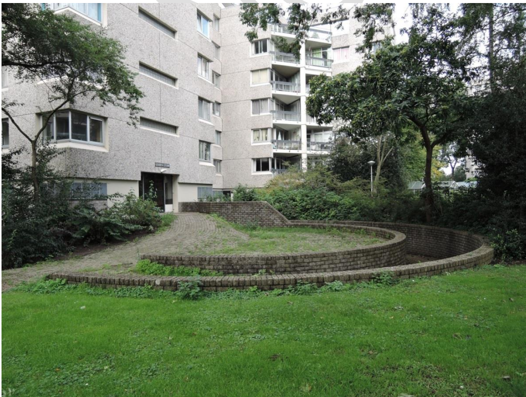
Gouden Leeuw oostgevel, hellingbaan voor keldertoegang.
