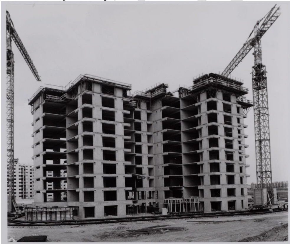
Groenhoven tijdens de bouw; de ter plaatse gestorte betonconstructie. Links op de achtergrond flat Gouden Leeuw. (Stadsarchief Amsterdam, Collectie Archief van de Gemeentelijke Dienst Volkshuisvesting).
