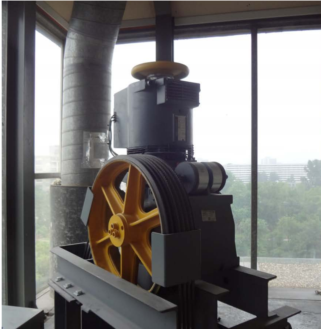
Liftmotor en regelkast
