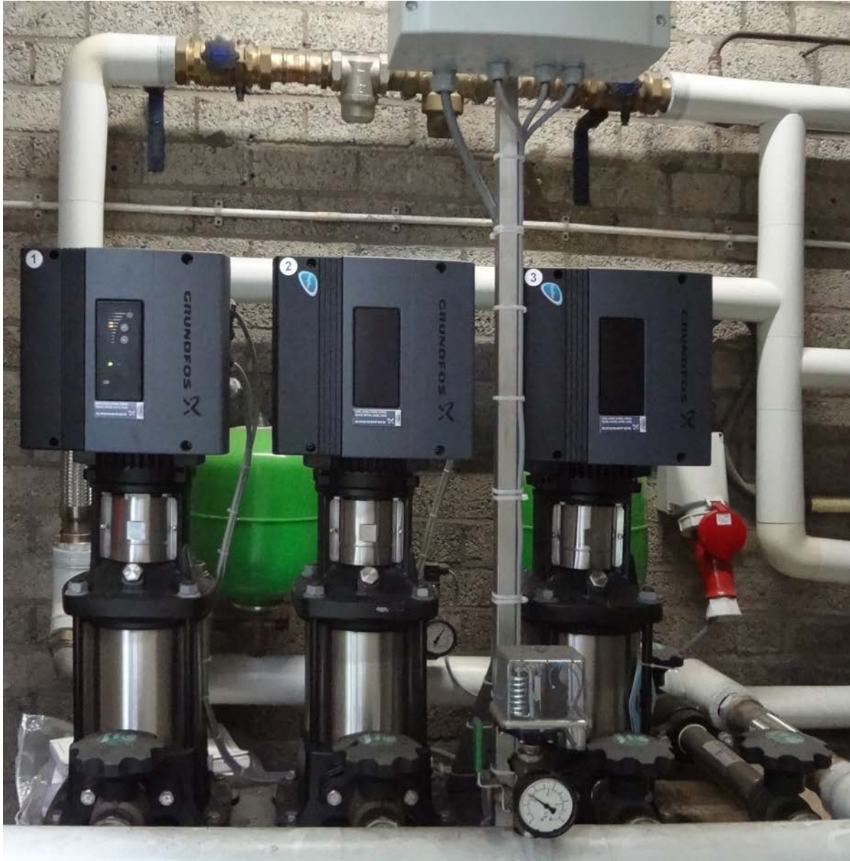
Hydrofoor installatie (drukverhoging voor het drinkwater)
