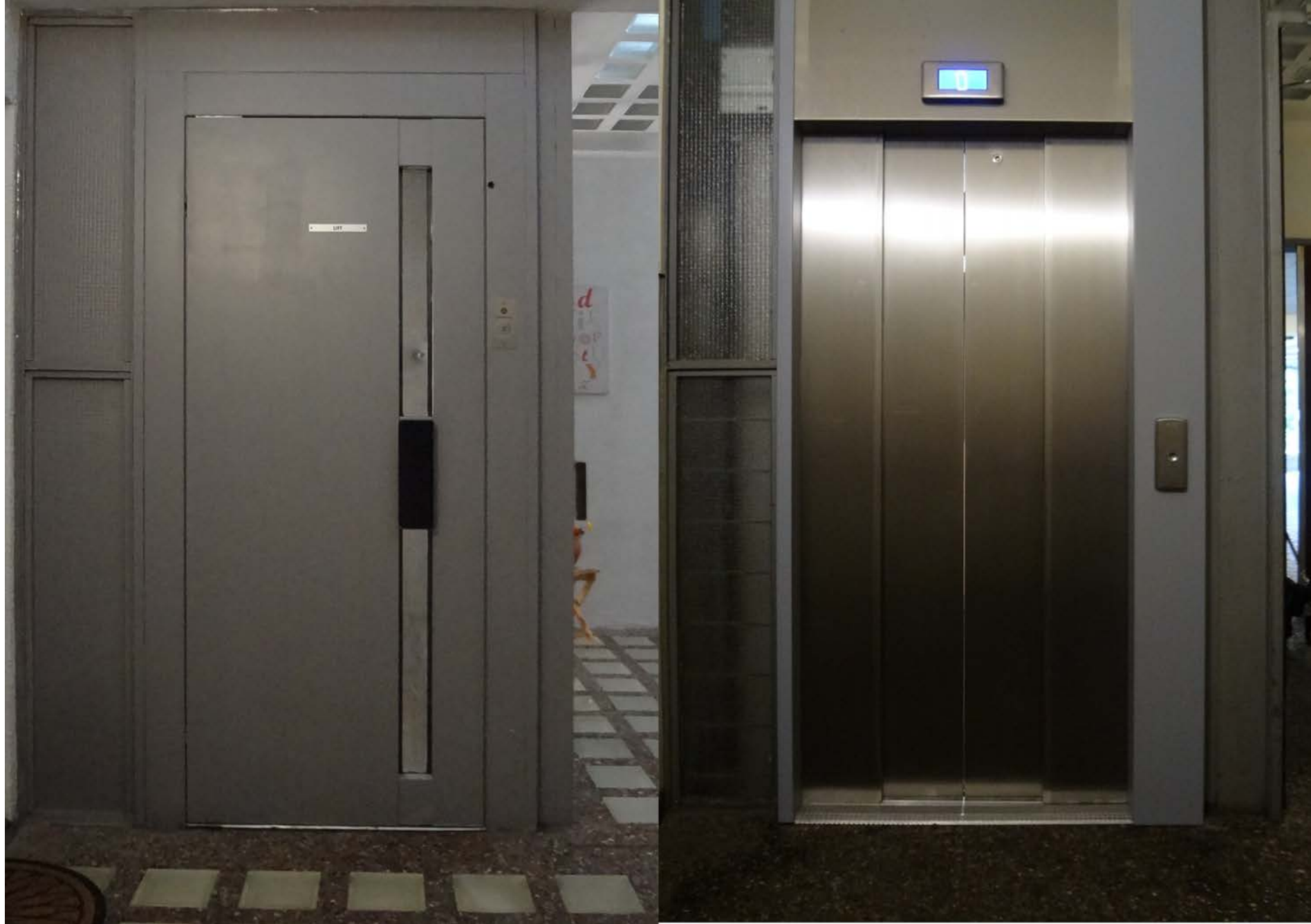
Oude liftdeuren en nieuwe liftdeuren (2021/2022)
