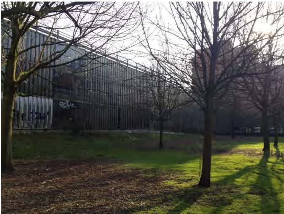
Eén van de parkeergarages binnen het plangebied
