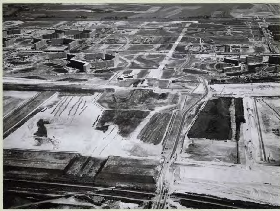
De Bijlmermeer in aanbouw rond 1970
