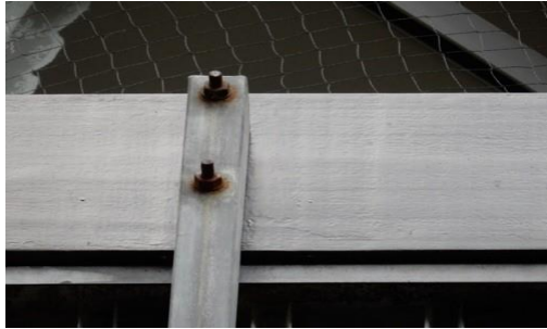
Roestig bevestigingsmateriaal
