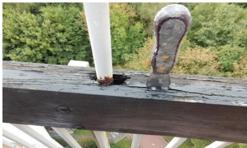
Houtrot, schadegevoelige detailleringen
